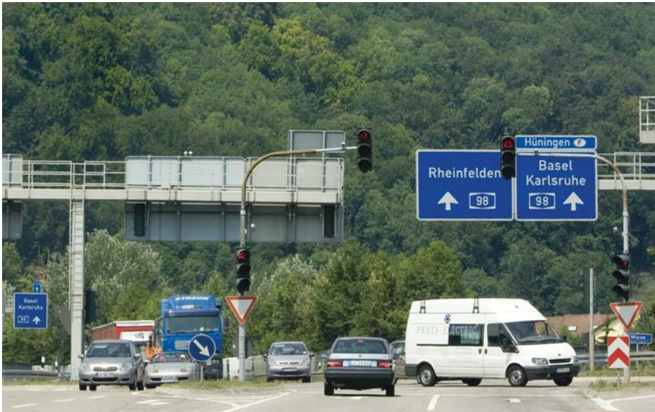
Neue Autobahn / Nouvelle autoroute: Weil - Rheinfelden
