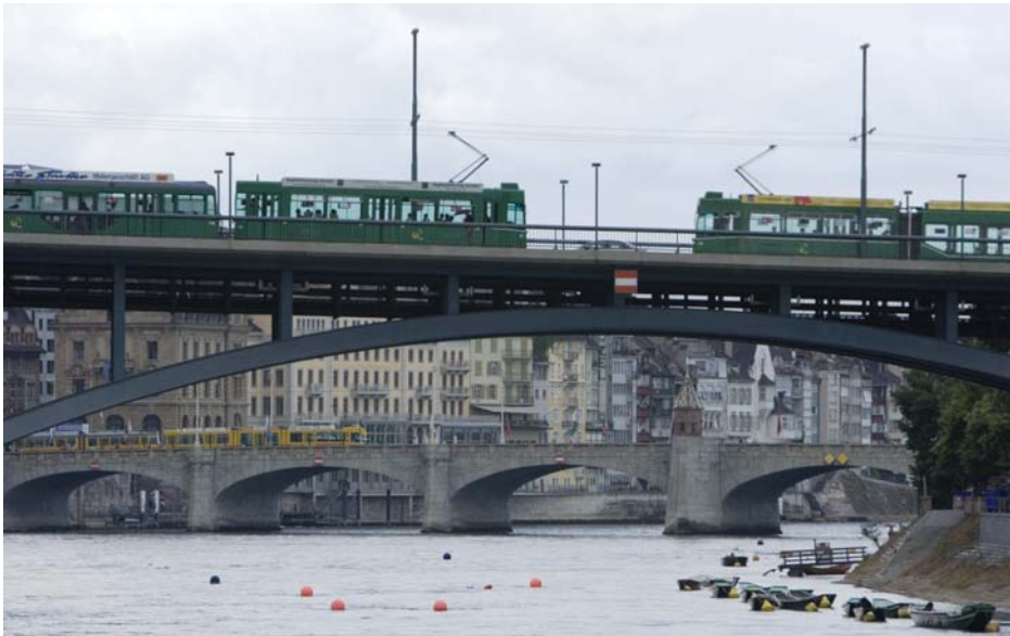
Innerstädtische Brücken in Basel / Pont urbain à Bâle
