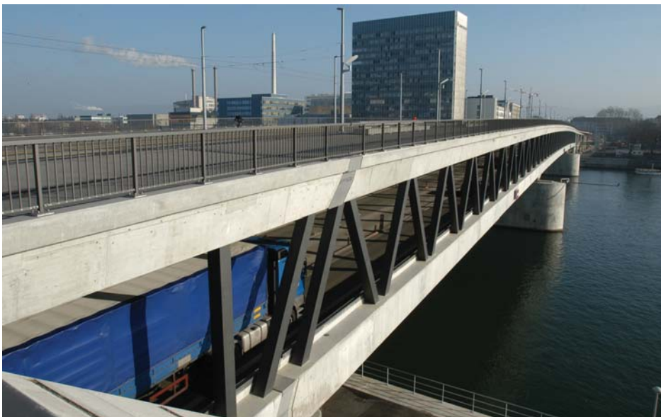
Nordtangente & Dreirosenbrücke Basel/ Tangente Nord et pont "Dreirosenbrücke" à Bâle
